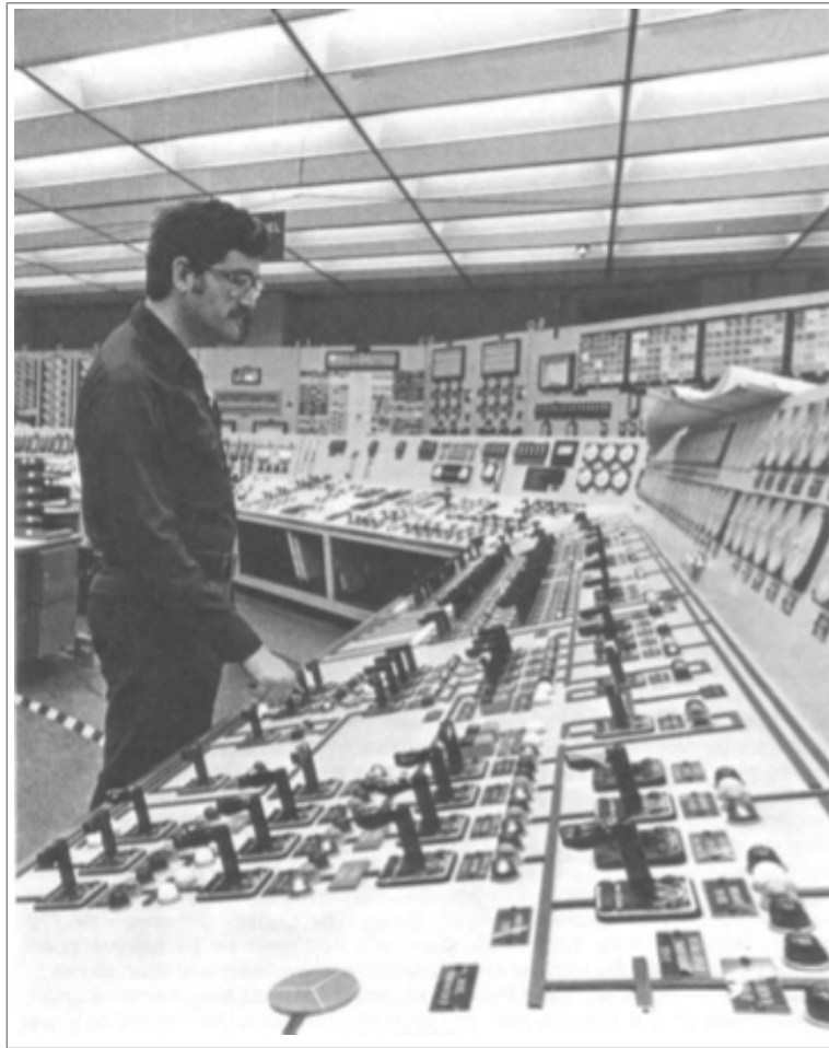
Fig. 2 TMI-2 Control Room (Rogovin 1980)
